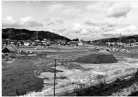
滝根地区統合小学校建設予定地
