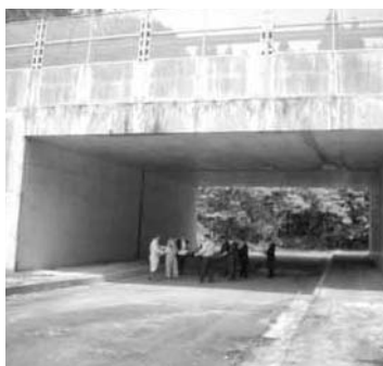
現地調査（大越町牧野地区）
