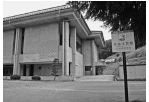
避難所表示板（大越体育館）
