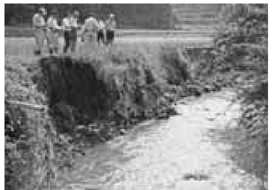
台風9号被災現場
