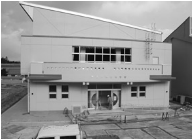
芦沢小学校屋内運動場改築工事
