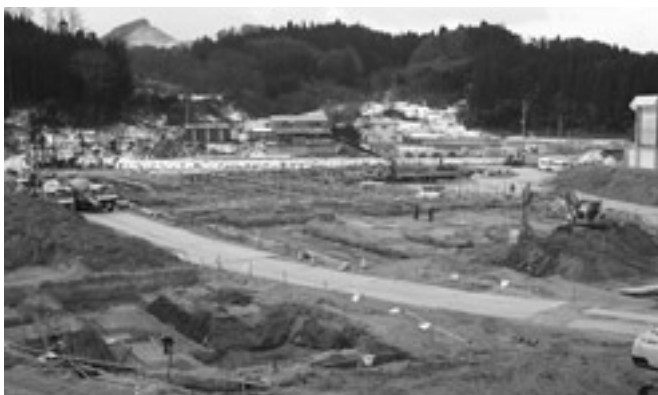
建設中の特別養護老人ホーム（常葉行政局管内）
