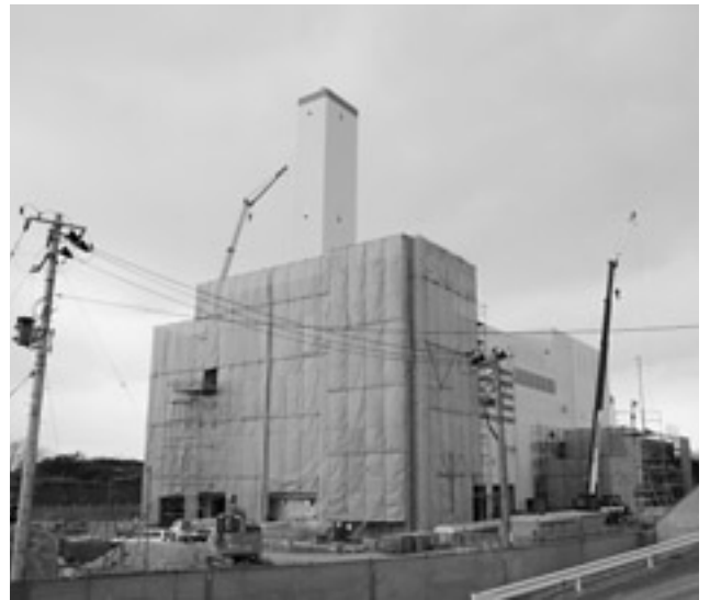
三春町に建設中の田村西部環境センター
