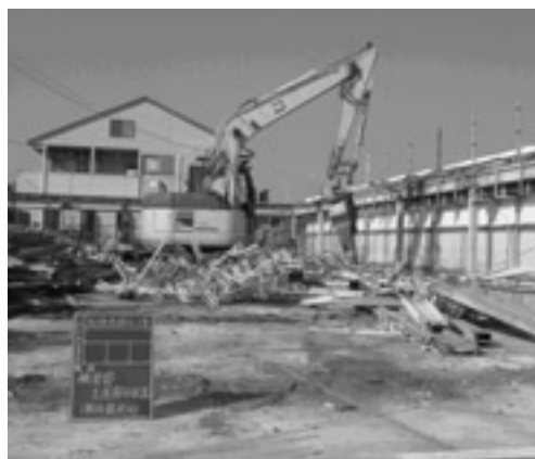
船引駅駐輪場 解体工事
