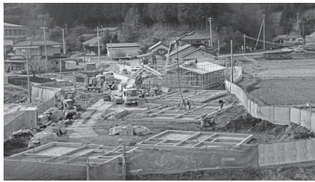
(今回市営住宅等条例に追加された都路地区公的賃貸住宅建設現場)
