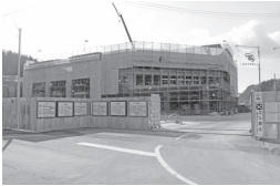
滝根地区統合小学校建設現場
