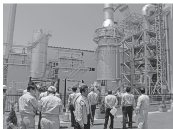
仮設焼却施設視察 (葛尾村)
