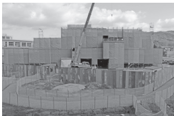
大越小学校建設現場
