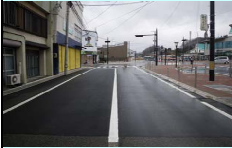
県道船引停車場線を始め駅前への道路は歩車分離されイベント時の安全な通行が可能となった。
