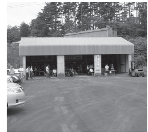
敷地内には2棟の検査施設を設置
