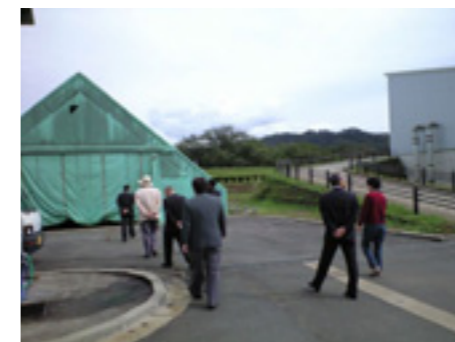
図3 脱臭設備（向かって左の建物）
