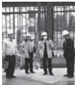
常葉中学校屋内運動場 建設工事現場
