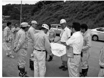
国道288号バイパス建設現場
