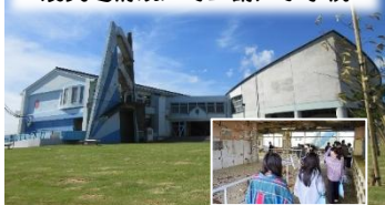
震災遺構浪江町立請戸小学校
