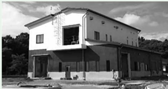
田村市・小野町の各家庭・事業所から発生するし尿・浄化槽汚泥を脱水・希釈し下水処理施設（大滝根水環境センター）へ投入する施設です。5年4月の運転開始に向け、現在、内装の仕上げや外構工事を行っています。
