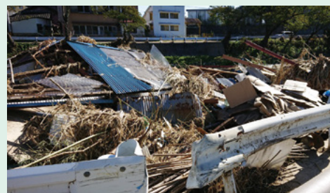
令和元年 台風19号による市内の被害状況
