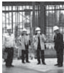
常葉中学校屋内運動場 建設工事現場
