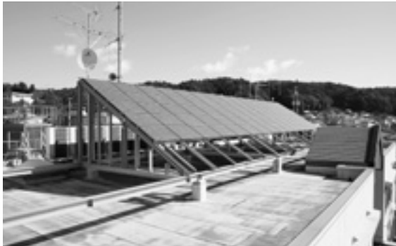
常葉行政局にある太陽光パネル
