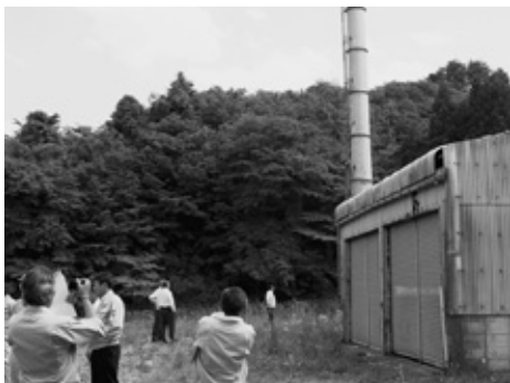
旧ごみ焼却施設（都路町）
