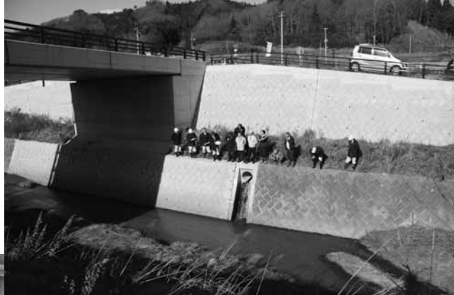
現地調査（滝根 原屋敷橋）
