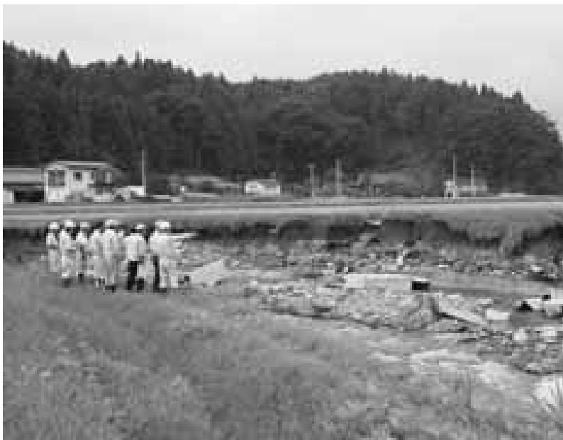
8月末集中豪雨被災現場の所管事務調査（都路町）
