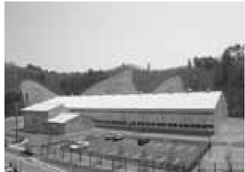
一般廃棄物最終処分場
