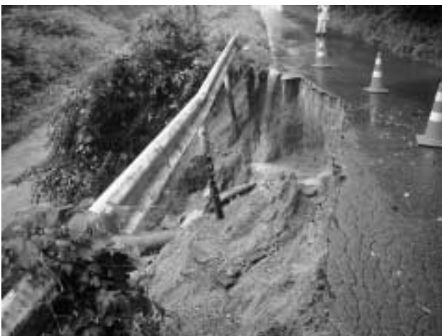
台風11号における災害現場 市道芹ヶ沢橋向線（都路行政管内）
