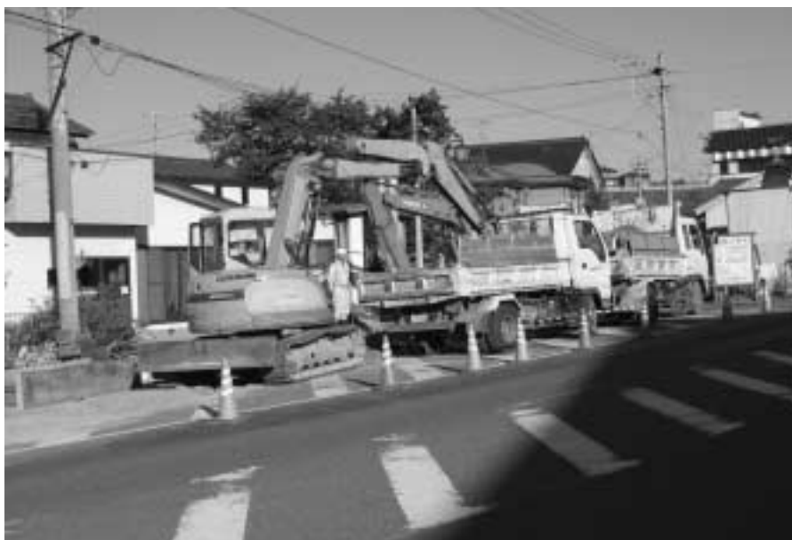
下水道工事（船引行政局管内）
