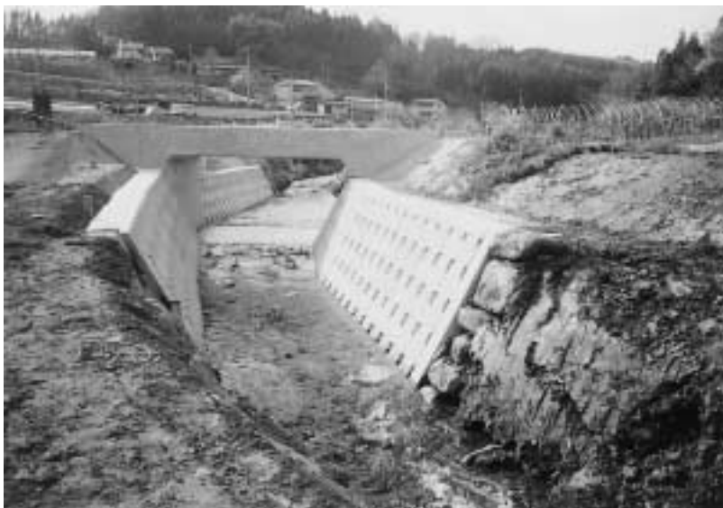
環境保全型ブロックを使用した工事 (船引行政局管内)
