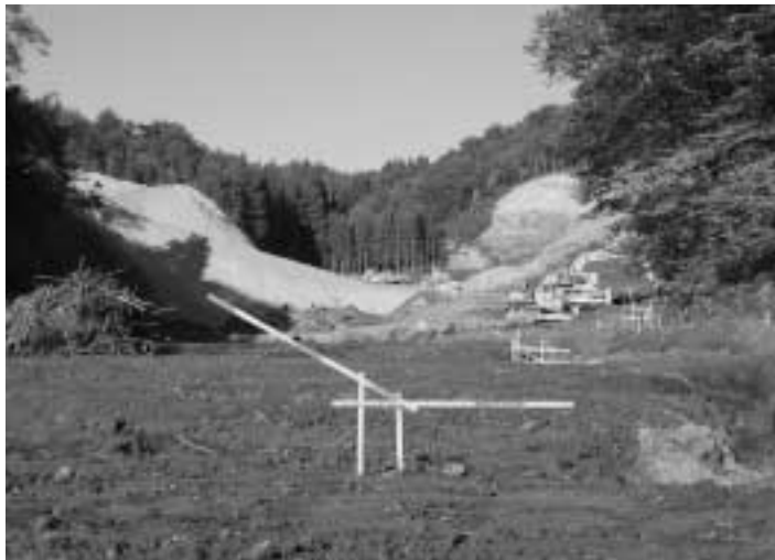
一般廃棄物処分場建設現場（常葉行政局管内）
