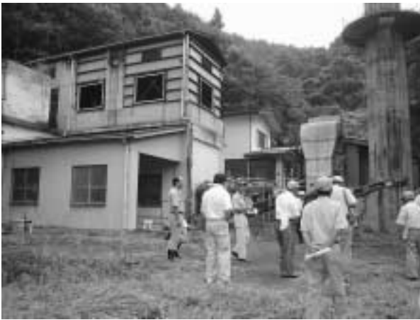
所管事務調査（大越焼却場）
