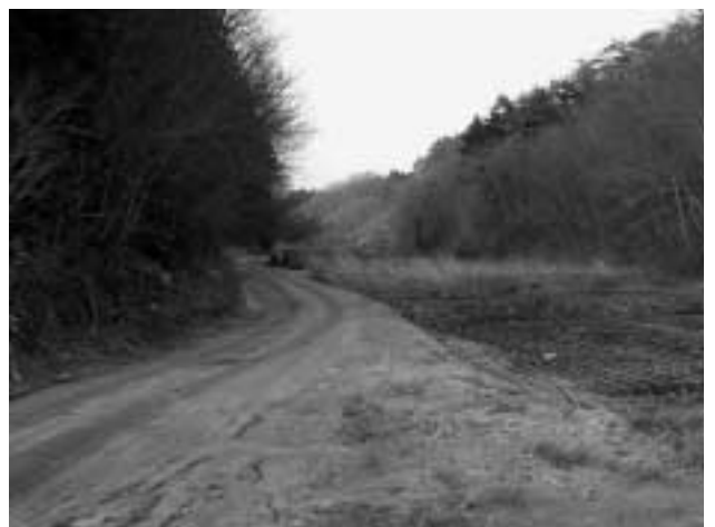
一般廃棄物最終処分場建設地 (田村市常葉町西向地区)
