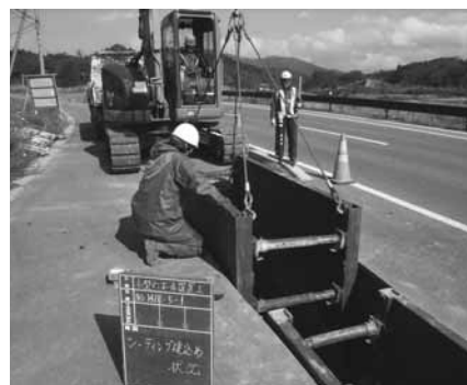
（写真）下水道管敷設
