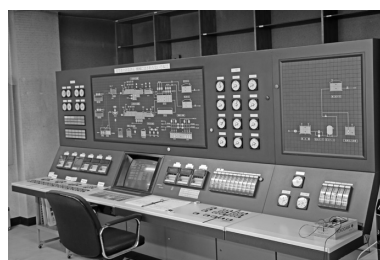
現在の船引浄水場中央監視設備
