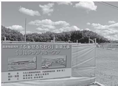
農畜産物直売所建設予定地 (船引町船引字遠表地内)
