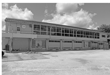
現在の船引中学校体育館
