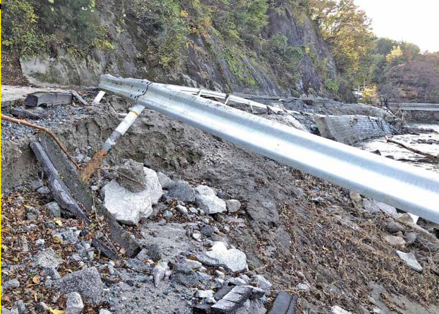
▲台風19号で被災した道路(船引町芦沢地区)
