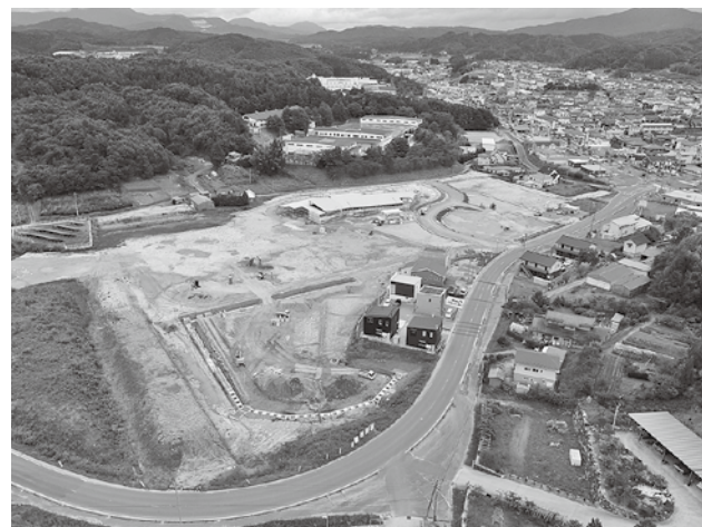
▲新市民病院建設地※中央奥は建設中の新船引保育所
