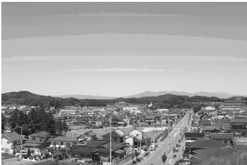
完了後の土地区画整理事業区域内（船引町東部台）
