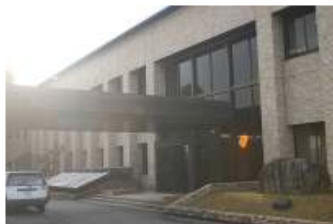
会津若松市下水浄化工場（管理棟）
