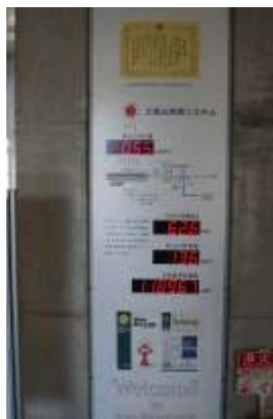
太陽光発電システム情報表示装置
