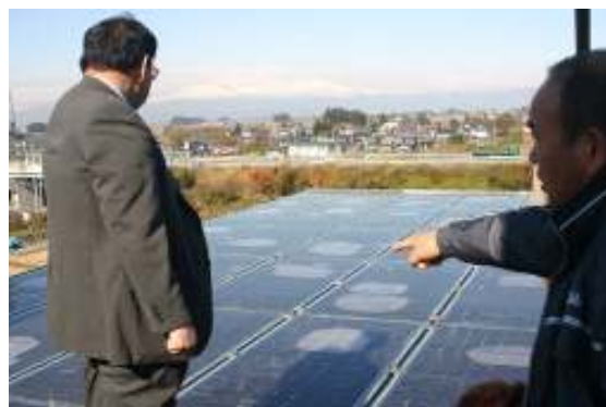
建物西側部分に設置された半透光型太陽光発電システムの説明を受ける様子
