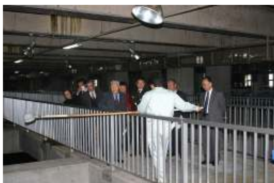
消化ガス発生工程の説明を受ける様子 (最終沈殿池)
