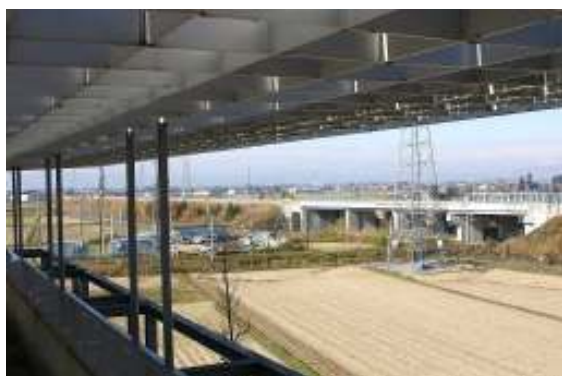
施設のすぐ北側を磐越自動車道が通行している
