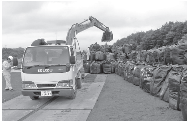
市内の除染作業を最優先で進めています
